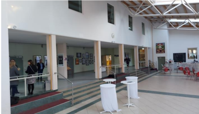
Aula Die Aula ist abgesenkt und nicht barrierefrei erreichbar. Dies ist insbesondere auch für die Anlieferung der derzeit dort verortete Mittagsversorgung problematisch.
