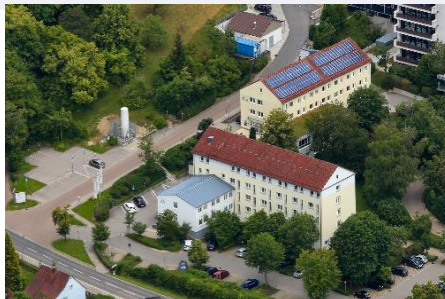
Landratsamt Kelheim Aussenstelle Hemauer Str. 48 Umbau/Sanierung Ausländeramt, 0,70 Mio. €
