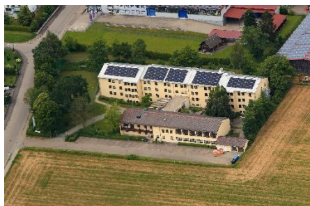
Schülerwohnheim Mainburg Dachenerneuerung/-dämmung Speisesaal 0,04 Mio. €
