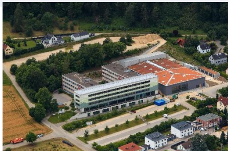
Staatl. Berufsschule FOS/BOS Kelheim Generalsanierung des Ost- u. Westflügels, Neubau Einfachsporthalle u. Sanierung/Ersatzneubau Werkstattgebäude, 46,9 Mio. €
